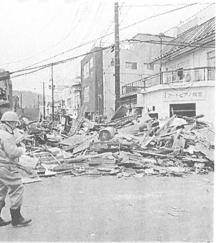
15日には釜石の被災状況を調査
