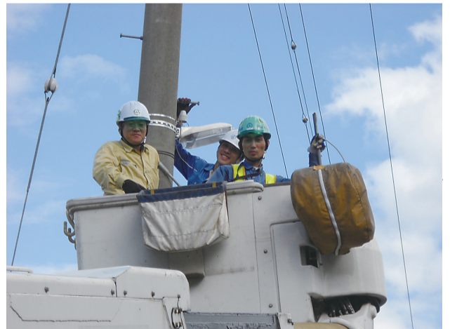
菅野部長(当時)も作業車に乗り施工 (大船渡中学校通学路)
