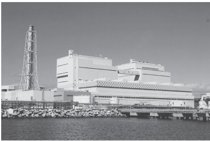
南相馬市にある原町火力発電所の全景
