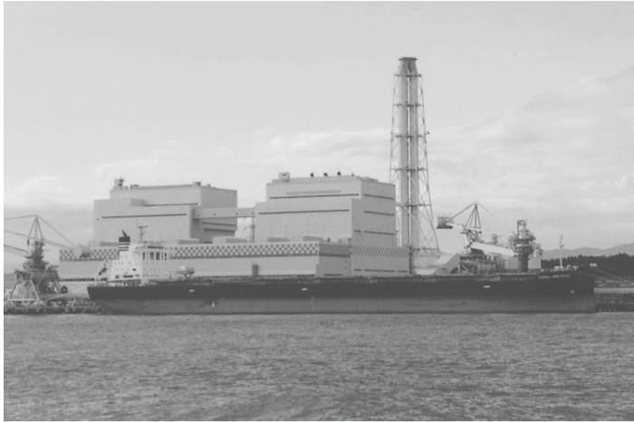
海から臨む原町火力発電所
